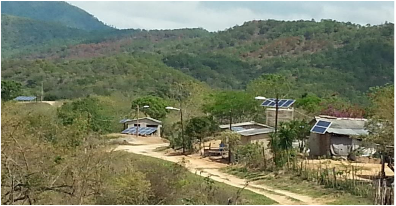
Figura 1. Implementación de Sistemas Energéticos en la Comunidad el Tuzal, municipio de Cintalapa, Chiapas.
